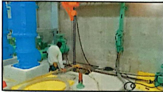
Ilustración No.2: Instalación de bomba y extracción de agua y aceite en el pozo de drenaje
