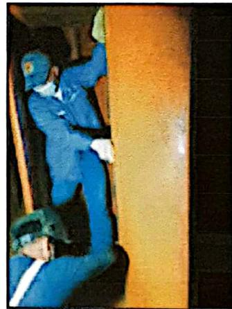
Ilustración No.1: Apertura de escotilla del Túnel de Conducción No.02 y soldadura de placas metálicas en alabes móviles.
