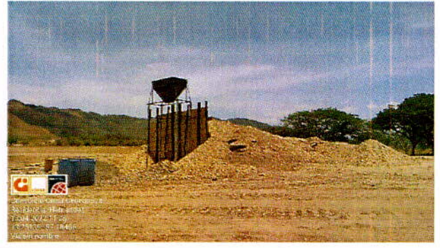
Instalación de Tolva para dosificar agregados de concreto en camión de 7 m3.
