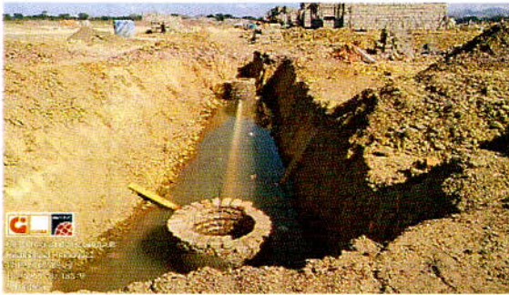
Instalación de Tubería Ø 8" y construcción de pozo N° 34 b y N° 35., avenida N° 12.
