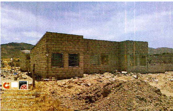
Instalación eléctrica y ventanas en Casa No 457, bloque M.
