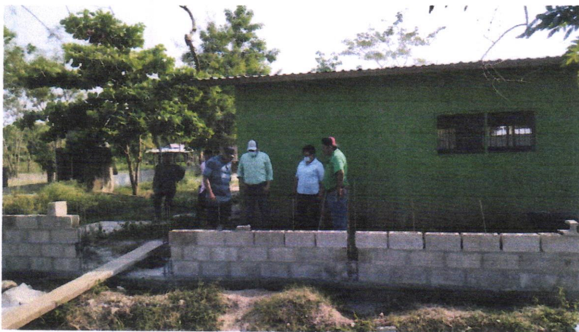
Visita de Campo en la comunidad de las Metálicas para la supervisión del Muro perimetral de la escuela Lempira.
