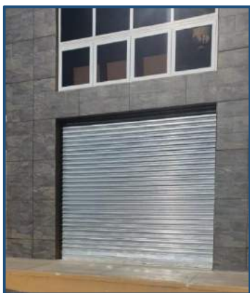
Almacén de Baja Rotación
