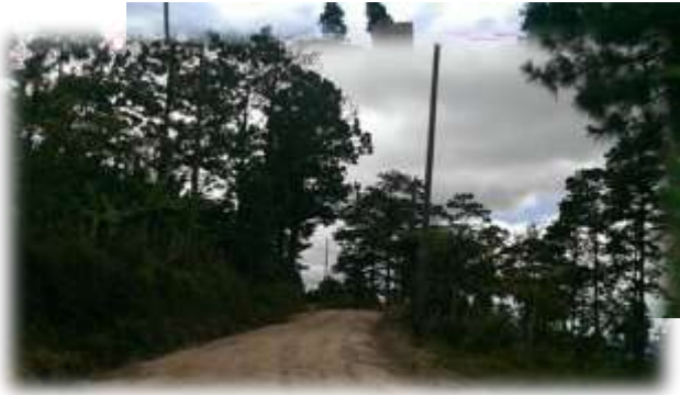
La Cienaga, Proyecto de Electrificación Rural
