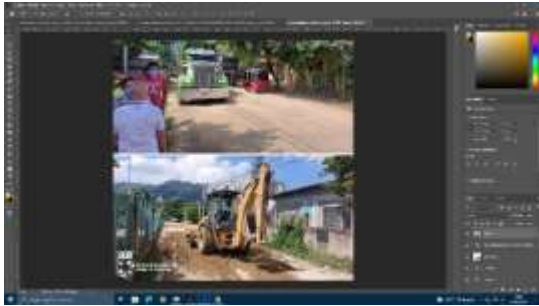
Reparación calle el sauce campana
