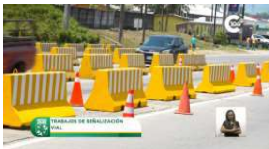
Pintado de señalización en el peaje
