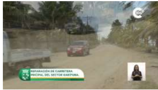
Reparacion de la calle garifuna
