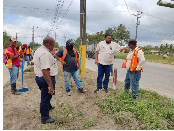
Supervisión en limpieza de Boulevard, entrada a Puerto Cortés
