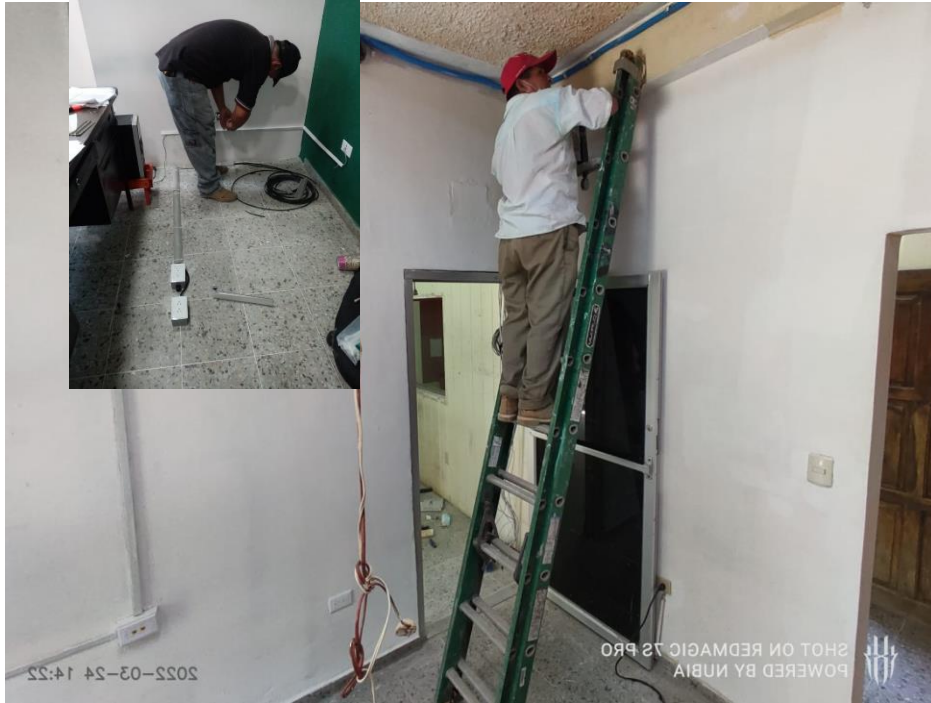
Pintado de paredes
