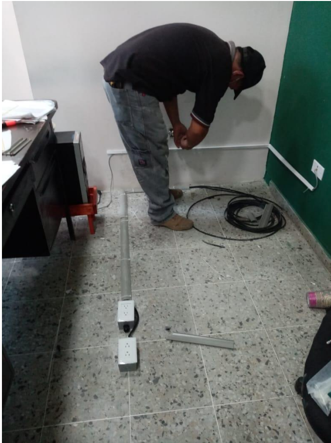
Instalación de tomacorriente
