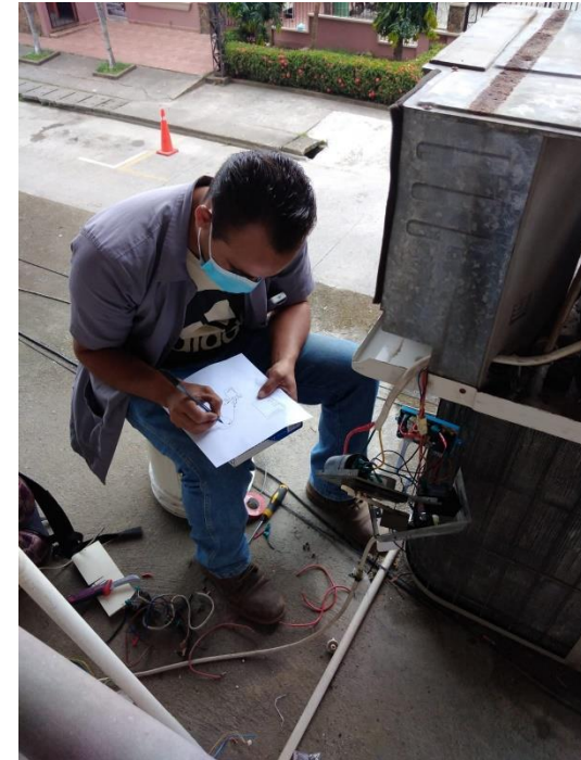
Instalación de placa universal
