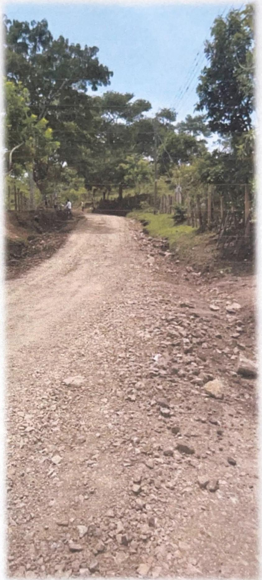
**SERVICIOS DE MANTENIMIENTO DE UNO PUNTO VEINTE (1.20 KM) DE CALLE, INCLUYE CONFORMACIÓN TIPO II (MOTONIVELADORA, VIBRO COMPACTADOR Y TANQUE CISTERNA), SUMINISTRO, CORTE, CARGA Y ACARREO DE MATERIAL SELECTO DESDE BANCO DE PRÉSTAMO UBICADO EN LA COMUNIDAD DEL DESTINO DE ESTE MUNICIPIO. WISILKA**
