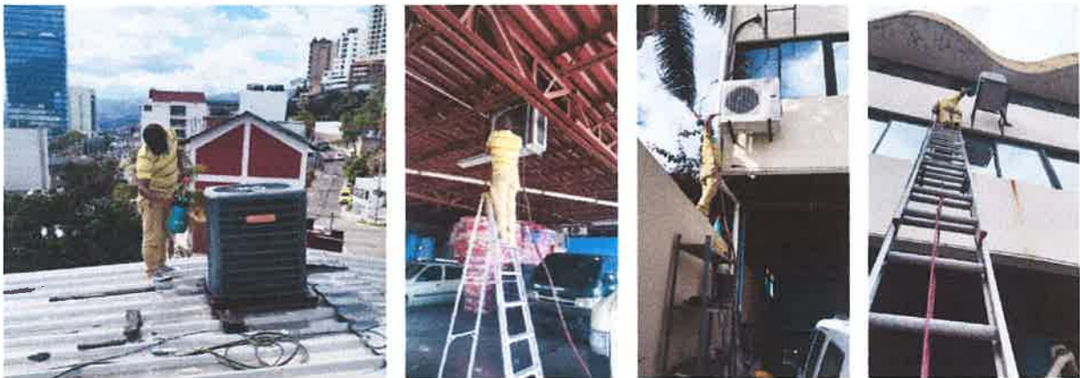
Fotografías 1. Limpieza de serpentines en unidades condensadoras.
