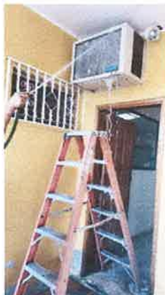
Fotografías 5. Lavado de unidad de ventana.
