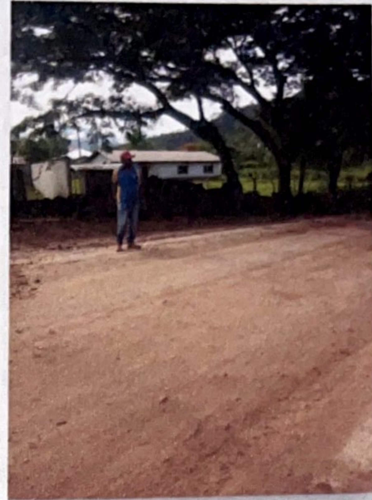
(Yorito, supervisión de arreglo de calles, trabajo en oficina)
