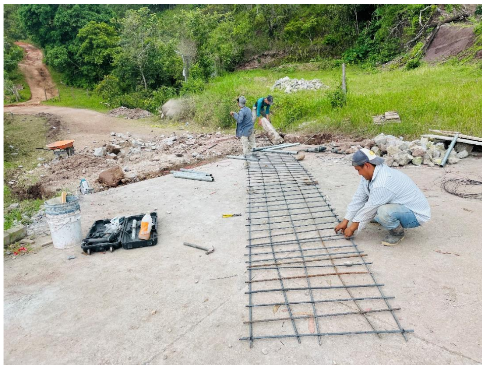
Construcción de alcantarilla
