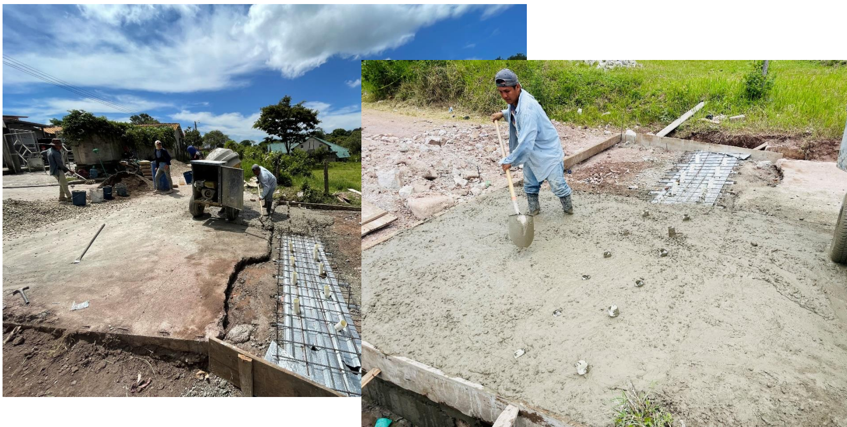
Colocación de concreto hidráulico.
