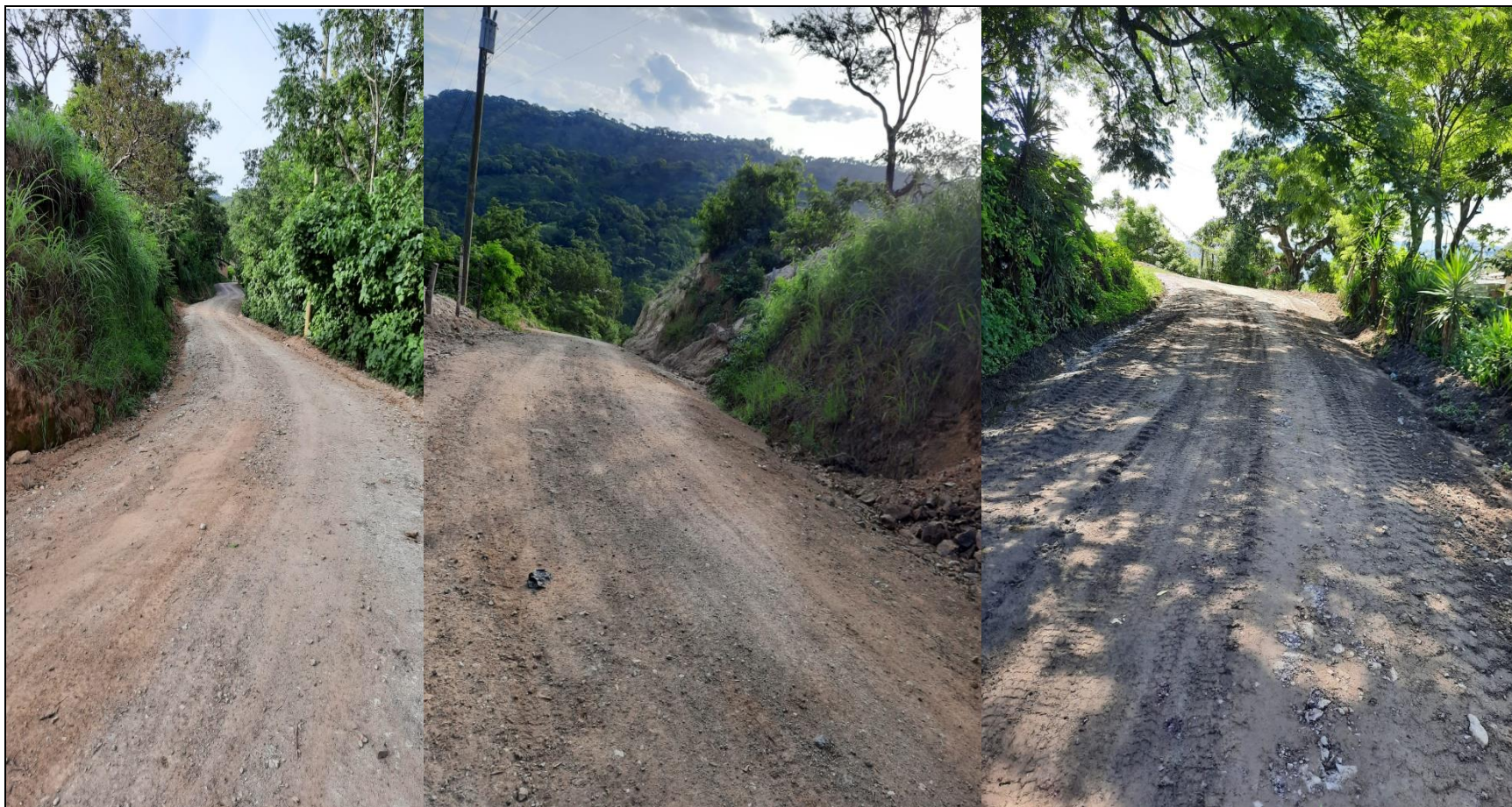
imágenes de la reparación del tramo carretero.
