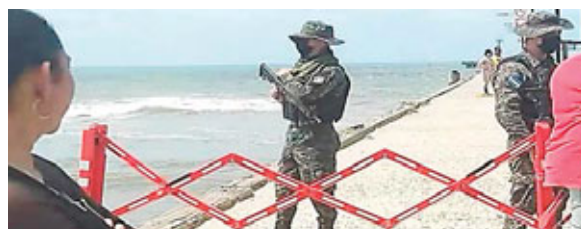
Militares se mantienen apostados en la mitad del deteriorado muelle de Tela, para restringir el paso de personas y el buceo en esa peligrosa zona.
