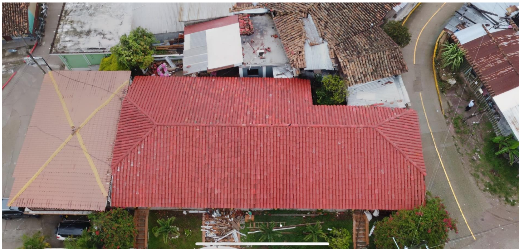
Pintura e instalacion de teja.
