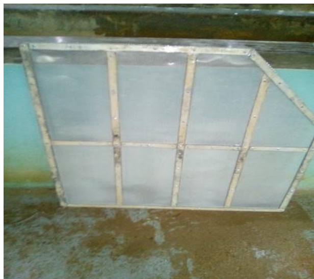
Se reparó las rejilla
