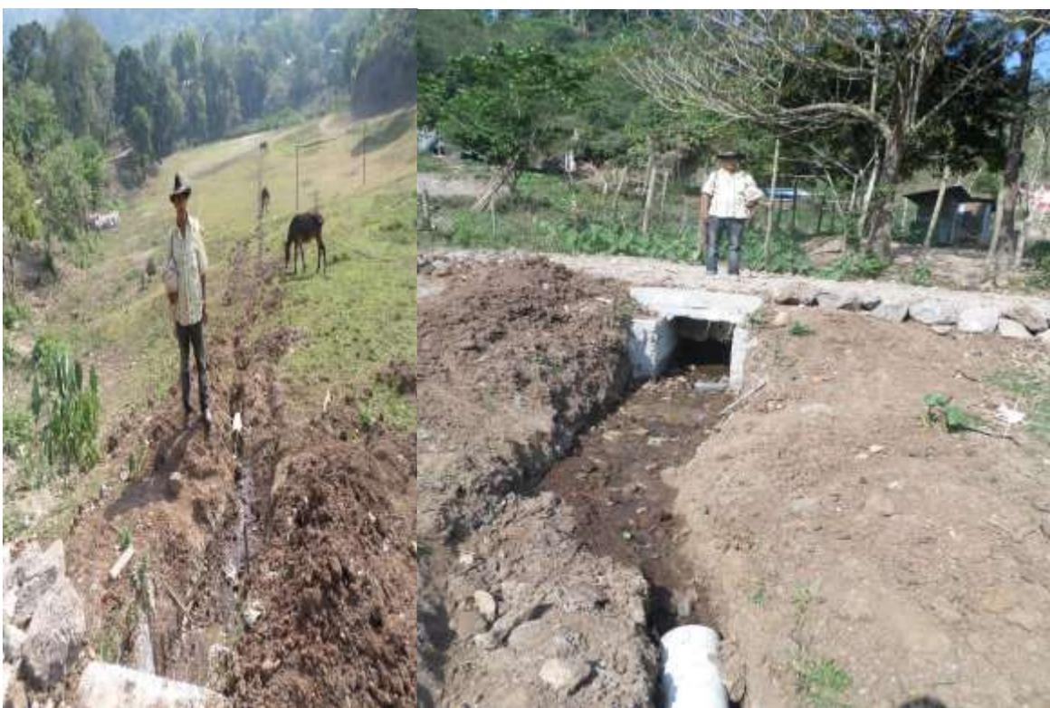
Las dos fotos superiores es donde sale el agua de la caja puente para conectarla al tubo y descargar abajo al final del campo de Foot Ball
