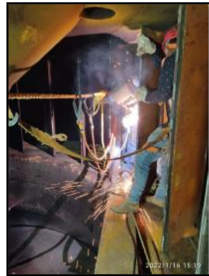
Ilustración No.2: Reemplazo de piezas metálicas en los Álabes móviles
