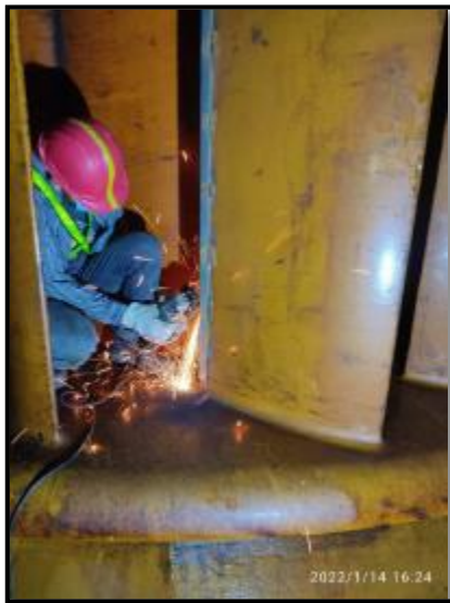
Ilustración No.2: Reemplazo de piezas metálicas en los Álabes móviles
