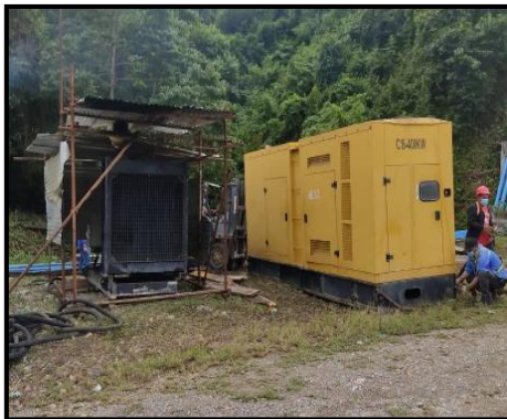
Ilustración No.1: Colocación de generador de 480KW, revisión de parámetros de funcionamiento
