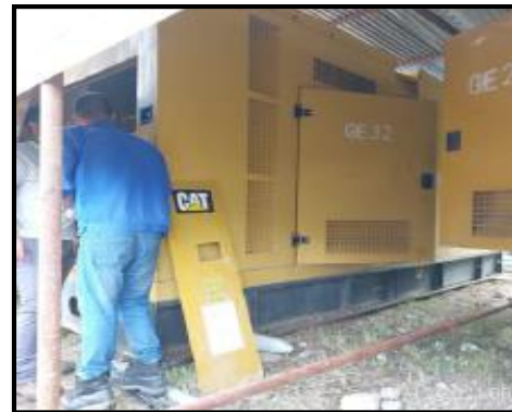
Ilustración No.1: Colocación de generador de 480KW, revisión de parámetros de funcionamiento
