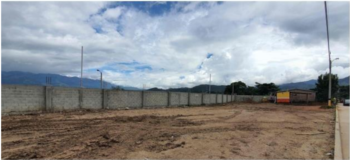
10) Inspección de Campo al Proyecto del Expediente 2021-SE-C-0227 - Solicitud de Permiso de Instalación (Proyecto EDS EL BIJAO) (Las Vegas, Santa Bárbara).
