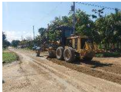
Reparación de calles y callejones de Bo. San Isidro, Sector Península Oeste
