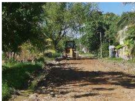
Reparación de calles y callejones de Bo. San Ramón, Sector Península Oeste
