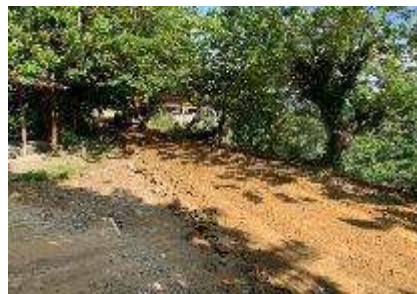
Reparación de Calles y Callejones de Barrio Palermo, Sector El Porvenir
