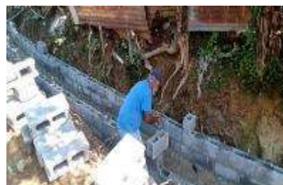
Inspección del Proyecto “Construcción de 184 metros de Canales Pluviales en la Col. Amigos del Campo, Sector El Chile
