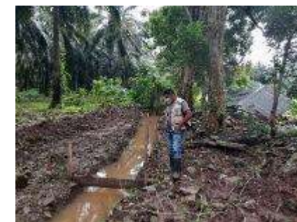
Supervisión del Proyecto “Construcción de Muro del Inst. Francisco Morazán de la Comunidad del Sofoco, Sector Tapón de los Oros
