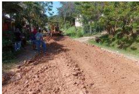
Mantenimiento de calles y callejones de la Col. Miraflores, Sector Medina
