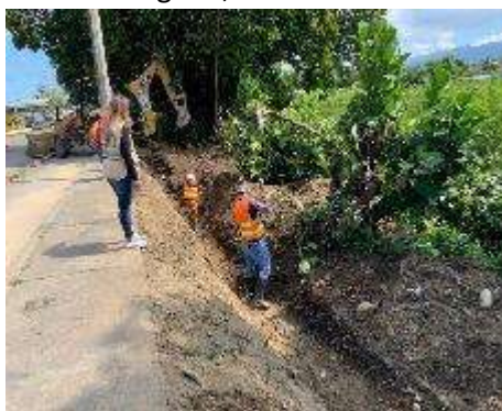
Apertura de canales naturales en Bo. Cienagueta, Sector El Porvenir
