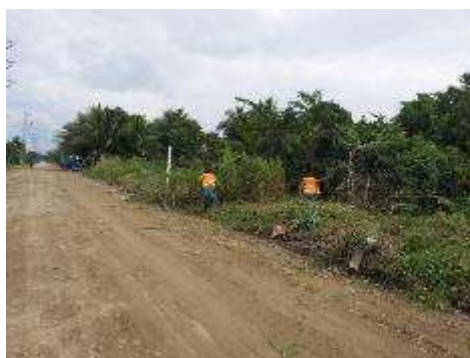
Limpieza de solares baldíos en Bo. Los Mangos, Sector Península Oeste.
