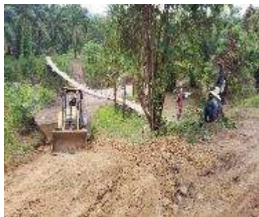
Reparación de rampa en el rio Botija De la Comunidad de la Uva, Sector Ramal de Lima.
