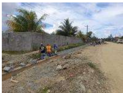
Inspección del Proyecto “Canales Pluviales” en la Col. La Esperanza, Sector Nuevos Horizontes
