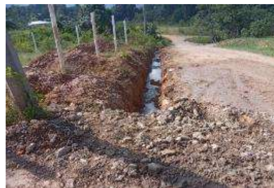
Apertura de canales naturales en el Bo. Medina Sector Medina
