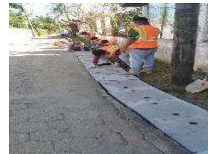
Supervisión en la Instalación de tapaderas en el callejón pulpería Vanesa de Bo. Cienaguita, Sector El Porvenir
