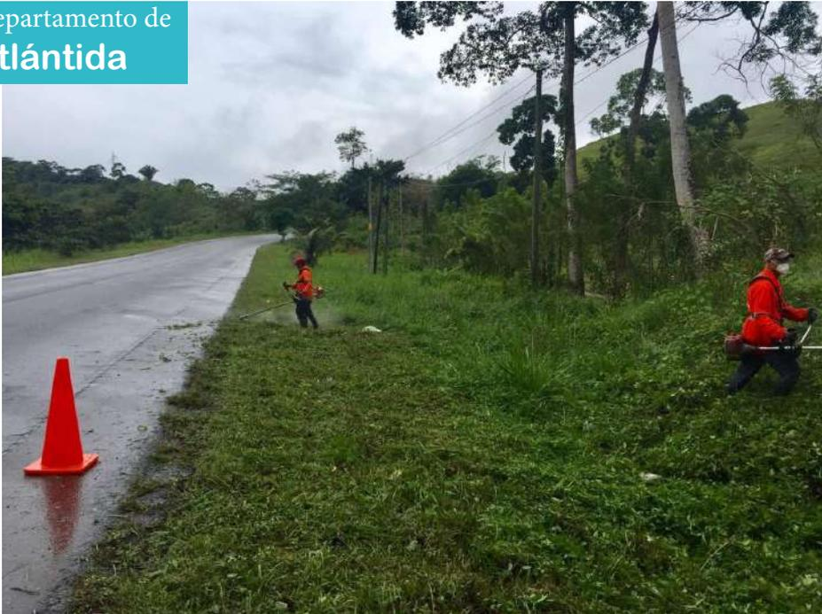
Gracias a los trabajos de limpieza realizados por la microempresa vial La Masica, en la carretera CA-13, a la altura de Puente Lean – San Juan Pueblo, se ofrece mayor visibilidad, seguridad y presentación en 16.69 kilómetros de infraestructura vial. Con estas acciones de limpieza del derecho de vía, Inversión Estratégica de Honduras garantiza a todos los usuarios de esta vía de acceso, la libre locomoción de los habitantes del municipio de Arizona, departamento de Atlántida.
