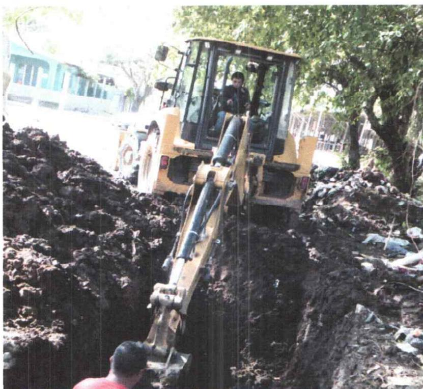
5. Reparación de tubería de 4" en Terraplén.
