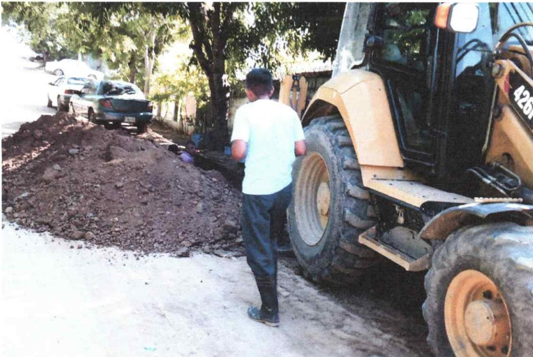
**7. Reparación de tubería de impulsión de 6" en Orquídea II.**
