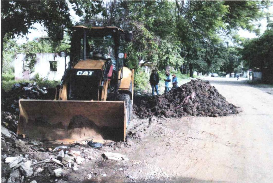
6. Reparación de tubería de impulsión de 3" en Bo. Las Lomas.
