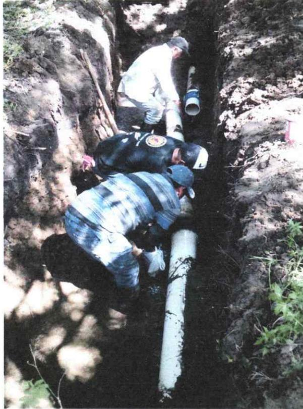
10. Reparación de tubería de 3" en descarga de bomba en Llanos de Canadá.
