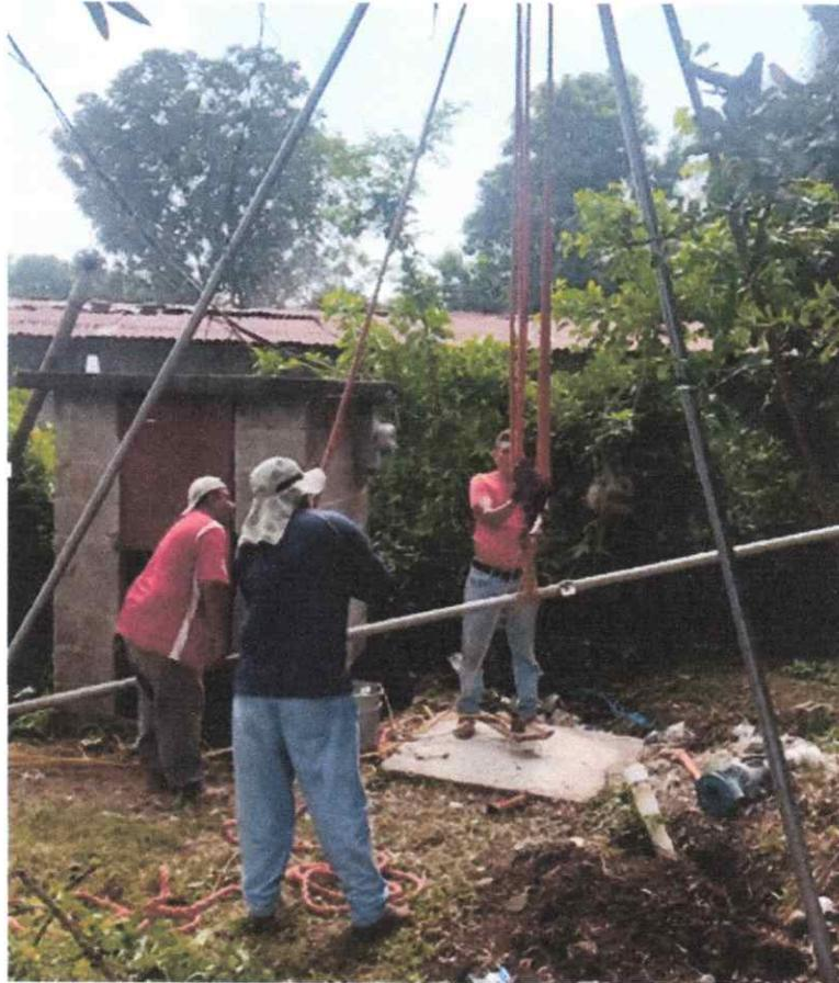
12. Electromecánica en Instalación de motor y bomba en pozo Rastro Municipal.
