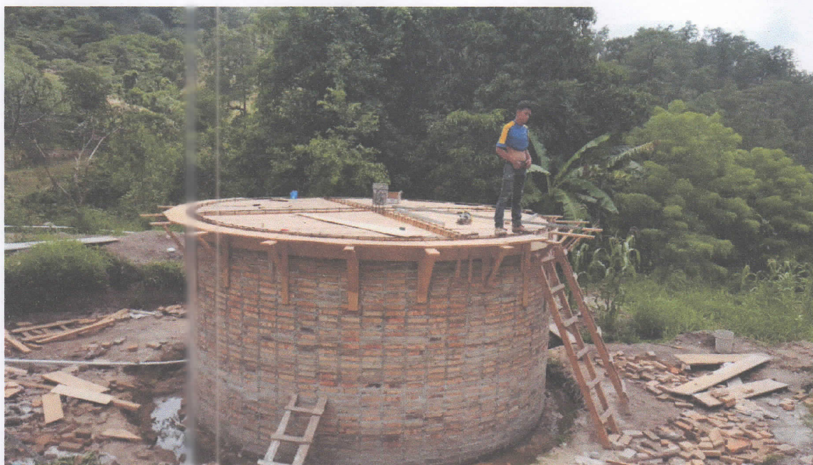
Sitio de Tanque
