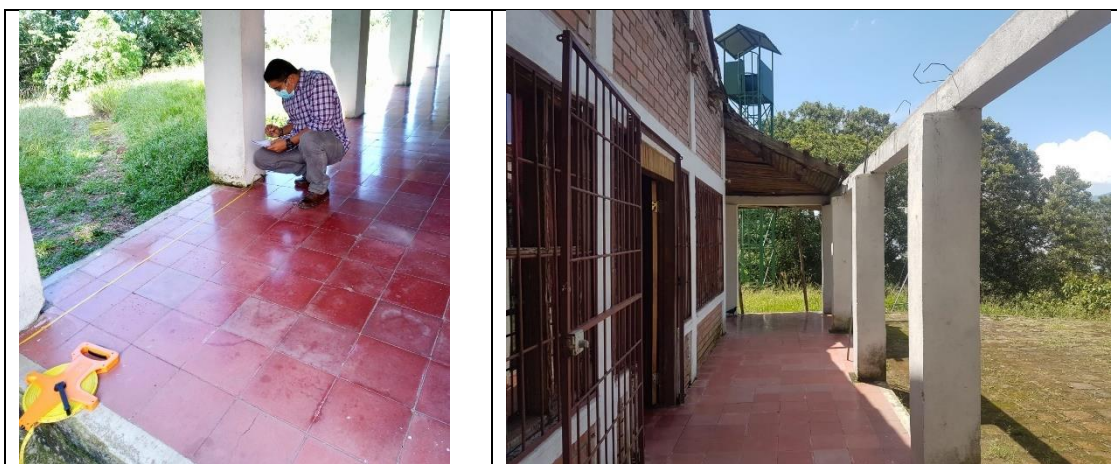
Inspección a la estructura de techo de las instalaciones donde se ubica AMUPROLAGO
