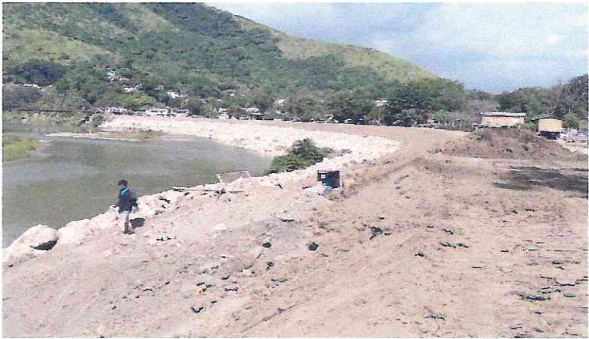
Avance físico Diciembre 2021 proyecto: Sobreelevación de Bordo y Obras de Protección Margen Izquierda del Rio Chamelecón, Puente Ferrocarril-Puente Fasquelle segunda Etapa, Sector Chamelecón.
