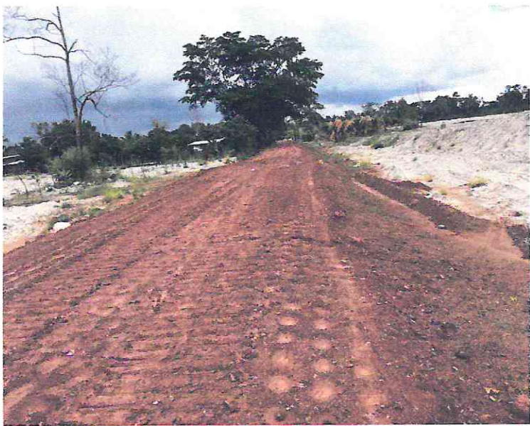
bordo concluido con material acarreado margen izquierda, aguas arriba de puente
