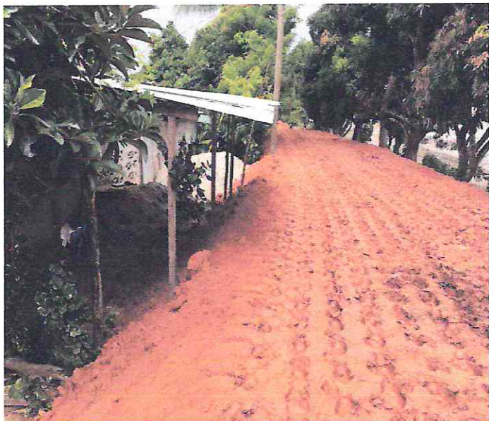
bordo concluido con material acarreado margen izquierda, aguas arriba de puente
