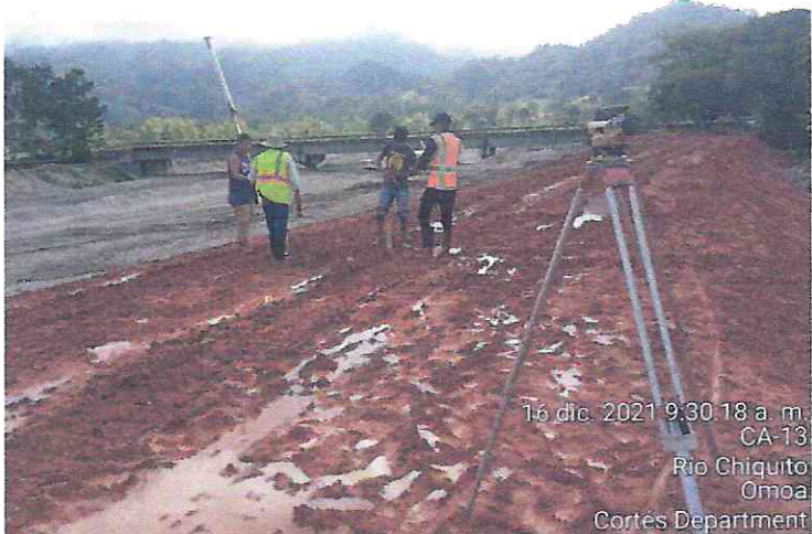
bordo concluido con material acarreado margen izquierda, aguas arriba de puente
