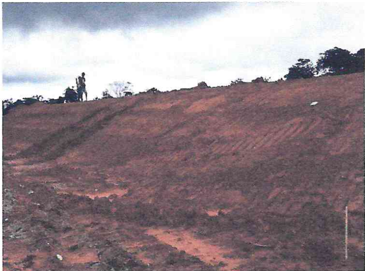
Bordo y geotubo concluido margen izquierda, aguas abajo de puente
