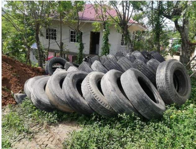
Traslado de llantas a colonia 30 de mayo para estabilizar terreno
