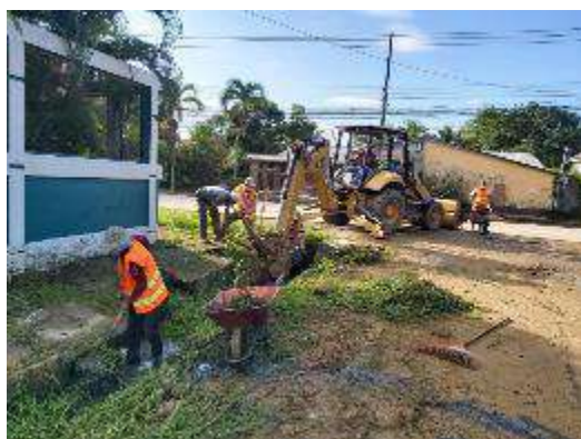
Limpieza de canales pluviales en Bo. Campo Rojo Sector Península Oeste
