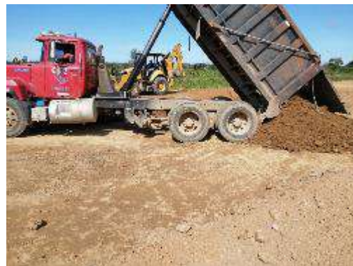
Relleno de la Cancha de futbol de la Col. 1 de mayo, Sector Nuevos Horizontes
