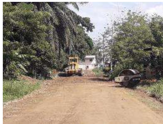
Mantenimiento de calle de Barrio Rio Mar, Sector El Porvenir
