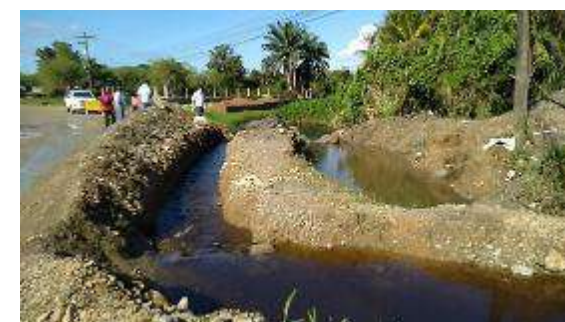
Inspección de la construcción de caja puente de la Col. 23 de abril, Sector Nuevos Horizontes
