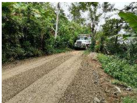
Mantenimiento de calle de Aldea la Presa, Sector Ecoturístico.
