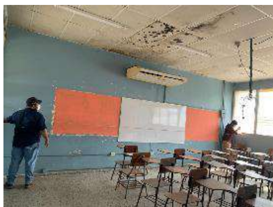
Supervisión del Proyecto “Techado de la Esc. Marco Aurelio Soto de Barrio El Porvenir, Sector El Porvenir
