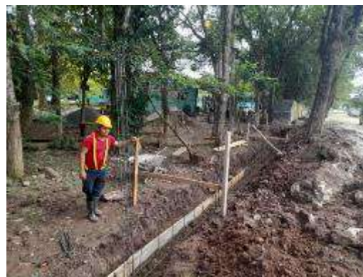
Inspección del proyecto “Muro del Inst. Francisco Morazán de la Comunidad del Sofoco, Sector Tapón de los Oros
