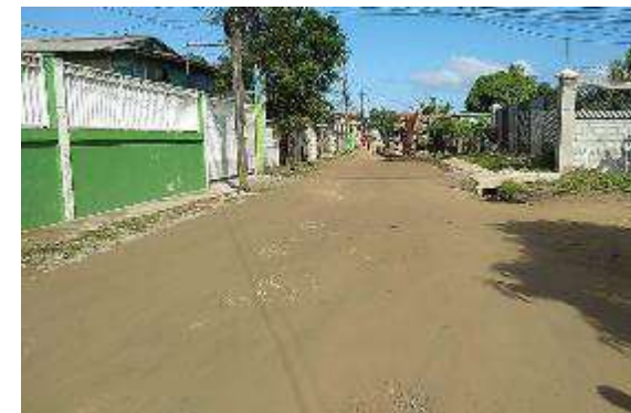
Supervisión de inicio de pavimentación del Callejón Nelly Brocato DE Barrio Palermo, Sector El Porvenir
