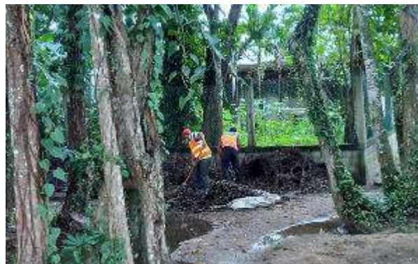
Limpieza del crique de Barrio Rio Mar, Sector El Porvenir
