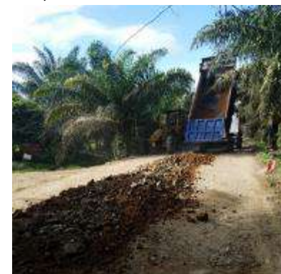
Mantenimiento de calle de la Comunidad de Calan, Sector Calan
