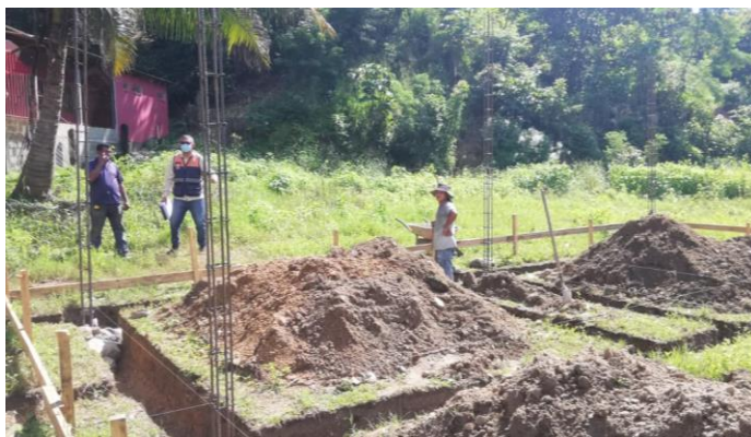
Orden de paro por construcción de vivienda en Aldea el Rondón.
