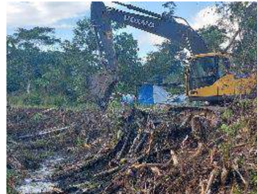
Limpieza de quebrada del macro-albergue de la Comunidad de Campana
