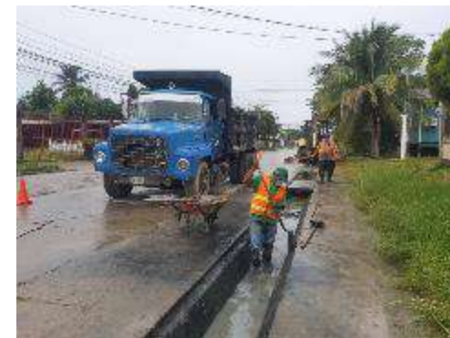
Limpieza de canales pluviales de Bo. San Ramon, Sector Península Oeste
