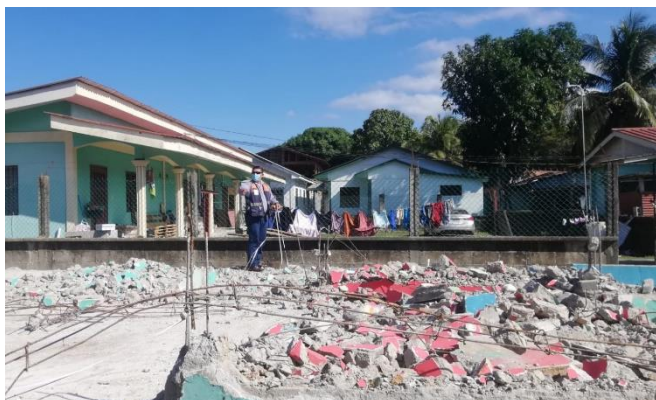
Inspección por solicitud de permiso de construcción de vivienda en Bo. El Centro.
