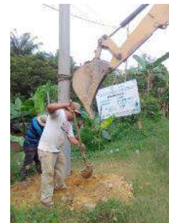
Donación de 1 poste de concreto para alumbrado publico de la Comunidad de Paleta, Sector Calan
