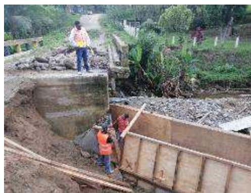
Inspección de reparación del Puente de San Antonio, Sector Ecoturístico
