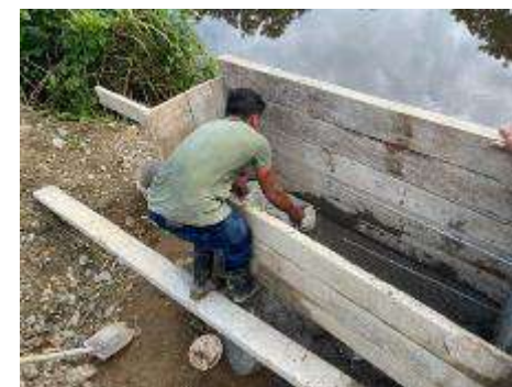
Inspección del Proyecto “Construcción de Cabezales de la Comunidad de Travesía Sector Garífuna
