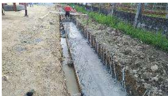
Inspección del proyecto de canales pluviales De la Col. La Esperanza, Sector Nuevos Horizontes
