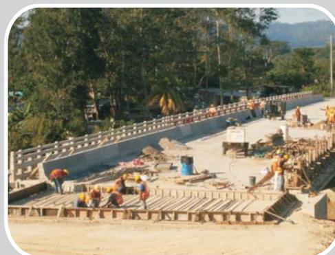
Trabajos de encofrado del último tramo del pretil en el Puente Bermejo que tiene 120 metros de largo.
