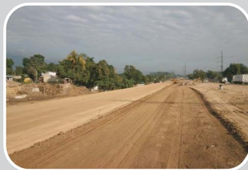
El tramo de 1.1 kilómetros está por ser finalizado. En la gráfica, vista de la sub-base ya terminada.
