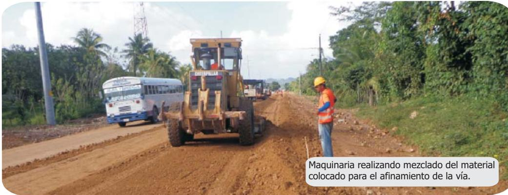
Maquinaria realizando mezclado del material colocado para el afinamiento de la vía.
