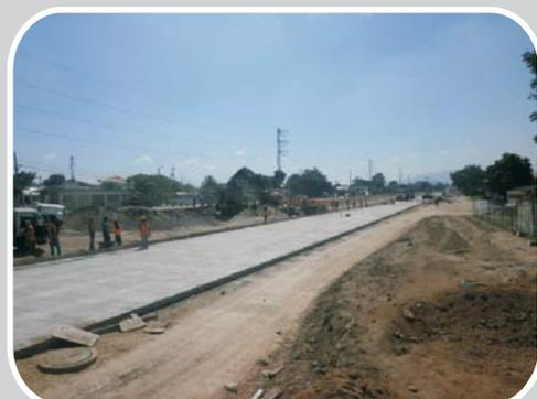
El tramo se pavimenta con concreto hidráulico e incluye construcción de bordillos y aceras, iluminación, área verde y señalización horizontal y vertical.
