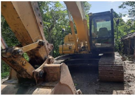
Inspección por DAC
