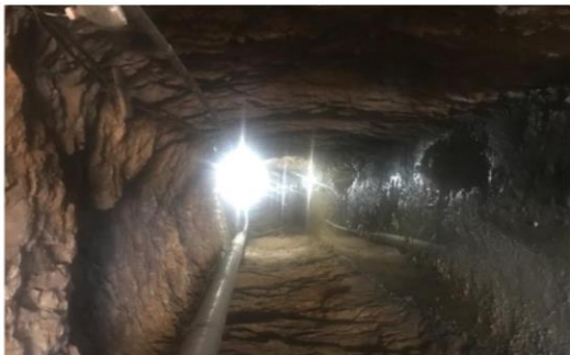
Túnel zona Baldoquin
