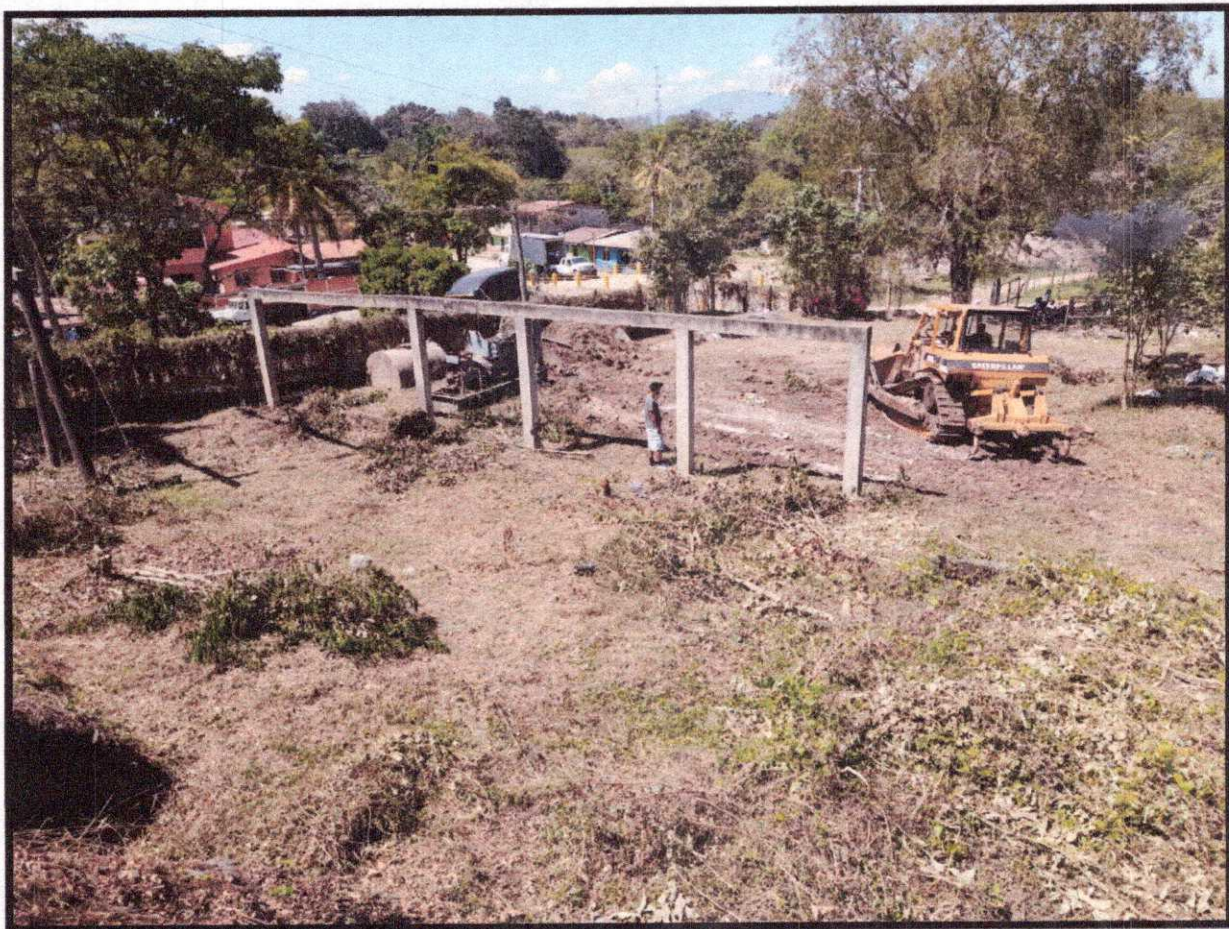
Nivelamiento de Terreno para la Restauración del Vivero municipal
