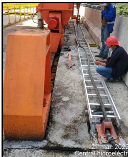
Ilustración No.1: Proceso de colocación de bandeja para protección de cable de energía de grúa.
