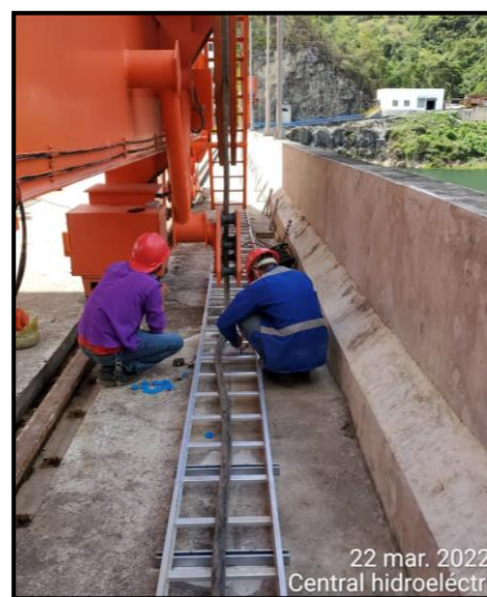
Ilustración No.1: Proceso de colocación de bandeja para protección de cable de energía de grúa.
