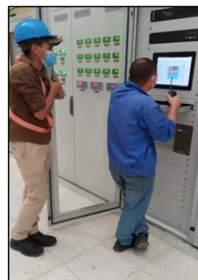
Ilustración No.3: Se realizan pruebas preliminares de eficiencia en la Unidad No.01
