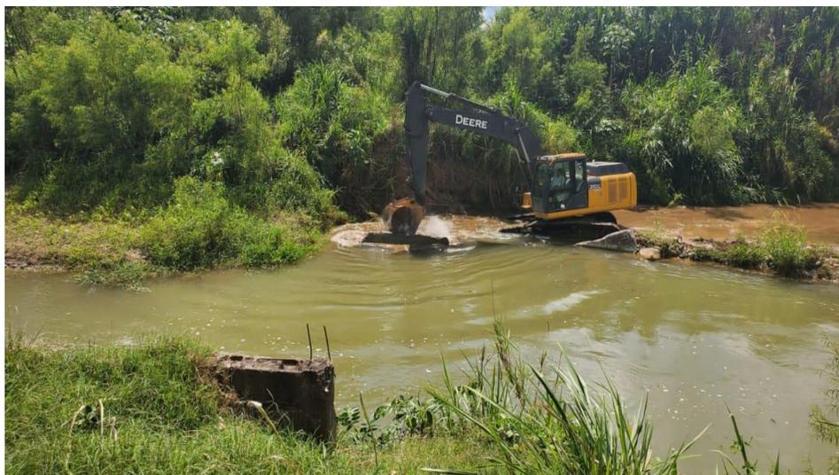
Maquina Excavadora 210-G en trabajos de dragado de río
