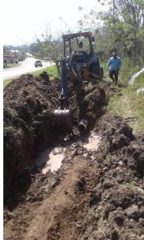
Se aprecia la maquina Retro excavadora 310-L en trabajos de excavación para reparación de sistema de agua potable
