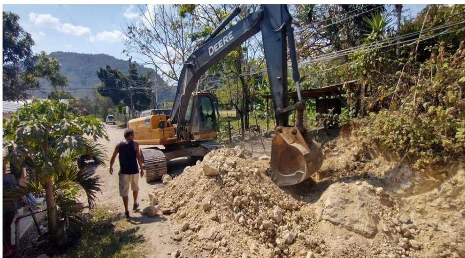
Se visualiza el trabajo de la máquina Excavadora 210-G en trabajos de corrección y alineamiento vertical de calle que da acceso a campo de futbol en Barrio Buenos Aires
