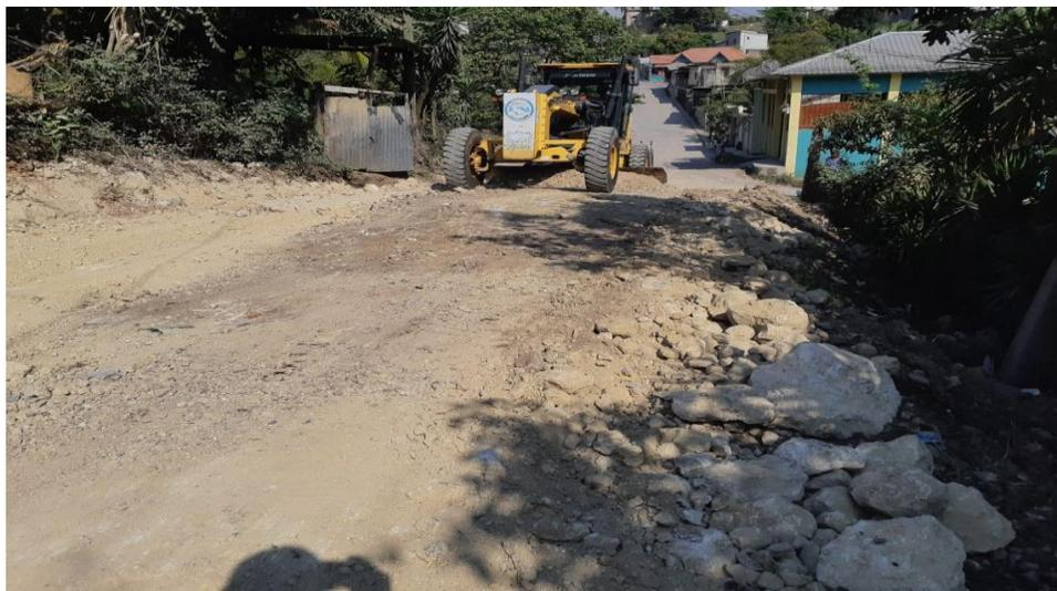
Se visualiza en la fotografía las maquinas Motoniveladora 670-G y Vibro compactador en trabajos de conformación, cuneteo y vibrado de calle que da acceso a campo de futbol en Barrio Morazán
