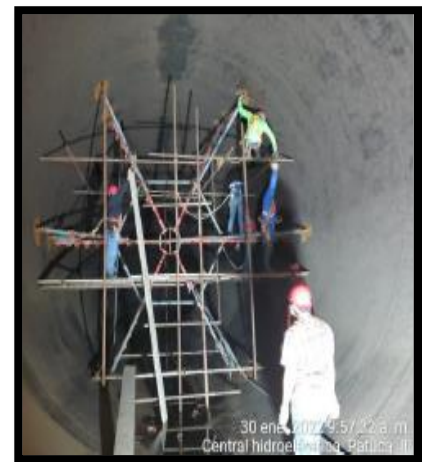
Ilustración No.1: Instalación de instrumentos para pruebas de preliminares eficiencia
