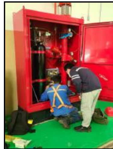
Ilustración No.2: Revisión del Sistema de inyección de nitrógeno de las Unidades No. 1 y No. 2
