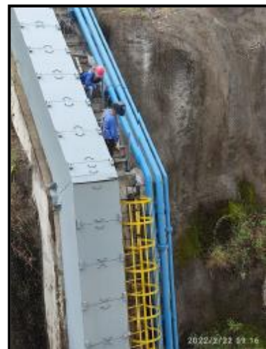
Ilustración No.3: Instalación de escalera marinera en talud posterior al cuarto auxiliar
