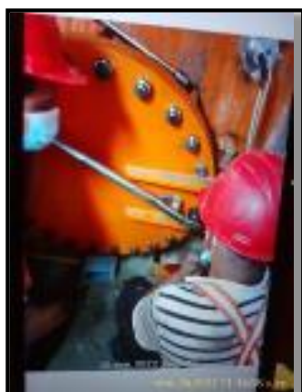
Ilustración No.4: Cierre de válvula hidráulica del codo de la cámara espiral de la Unidad No. 2
