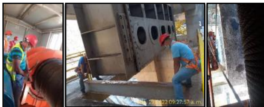
Ilustración No 5: Levantamiento de las compuertas de desfogue para completar el llenado de la cámara espiral de la Unidad No. 2
