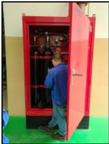
Ilustración No.2: Revisión del Sistema de inyección de nitrógeno de las Unidades No. 1 y No. 2
