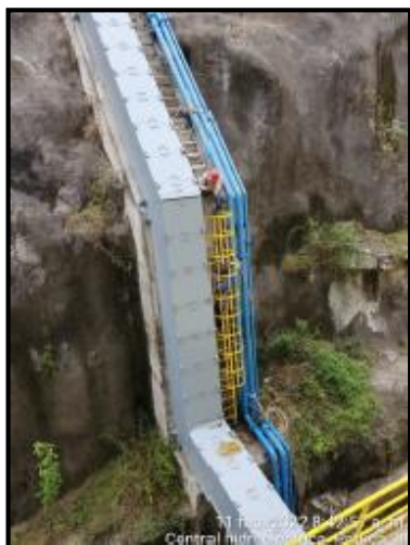
Ilustración No.3: Instalación de escalera marinera en talud posterior al cuarto auxiliar
