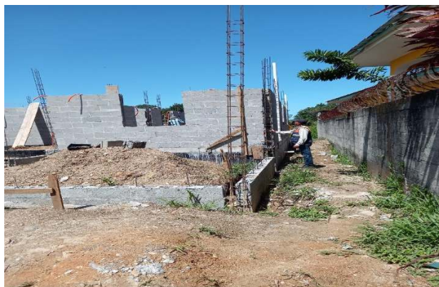
Inspección a solicitud de permiso de construcción de Vivienda en Barrio Rio Mar.
