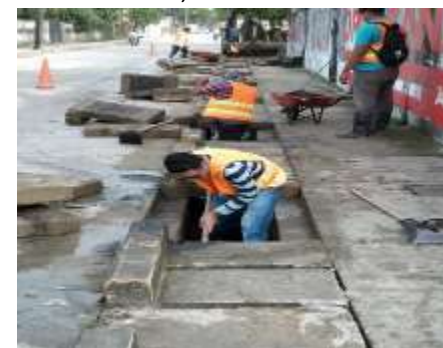
Limpeza de canales pluviales en el Bo. Pueblo Nuevo, Sector El Porvenir
