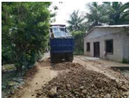
Reparación y mantenimiento de calle de las Comunidades de Robles y El Boquerón, Sector Tapon de los Oros
