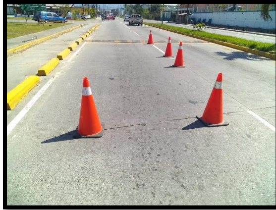
Instalación de vialetas Bo. Rio Mar, Frente a Hospital del Caribe
