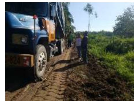
Reparación de calle de la Comunidad de KM6, Sector Calan.
