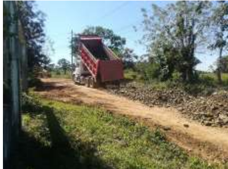
Reparación de calle de la Col. 18 de noviembre, Sector Chameleconcito
