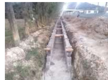
Inspección de Construcción de canales pluviales de la Col. 30 de mayo, Sector Delicias.
