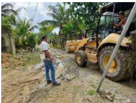
Reparación de las calles internas de La Comunidad de los Cruces, Sector Tapon de los Oros
