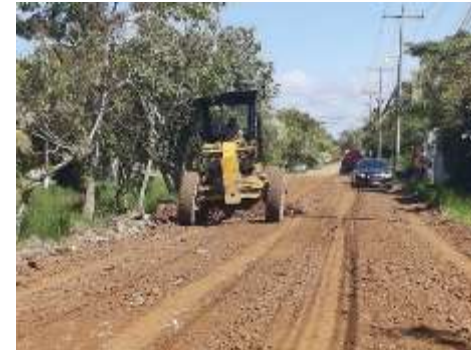
Mantenimiento de calle de macro canal de Bo. San Ramon, Sector Península Oeste 1
