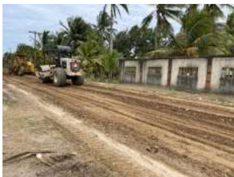
Reparación de calle principal de la Comunidad De la Barra de Chamelecón, Sector Garífuna.
