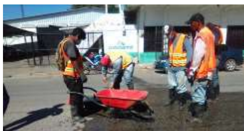
Limpieza de Drenaje de aguas negras en Bo. El Centro, Sector Península Este 2.
