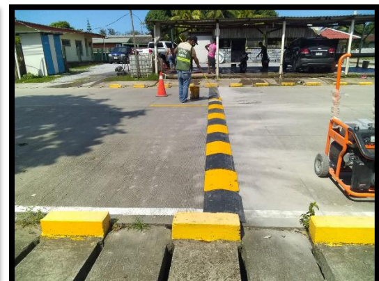
Reinstalación y pintado de reductor B. Copen 7 y 8 calle 6 avenida
