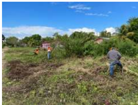
Limpieza de macro canal de la Comunidad de Travesía, Sector Garífuna
