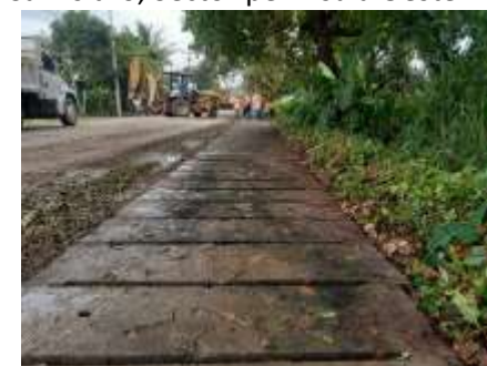
Limpieza de canales pluviales en Bo. San Isidro, Sector península Oeste 2
