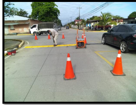
Instalación de reductor de velocidad en Bo. Suyapa 8 y 9 calle 6 avenida
