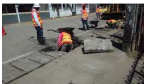
Limpieza de canales pluviales de Bo. El Centro, Sector Península Este 2.
