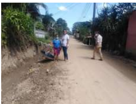
Evaluación de canales pluviales de Bully Champa, Sector Delicias
