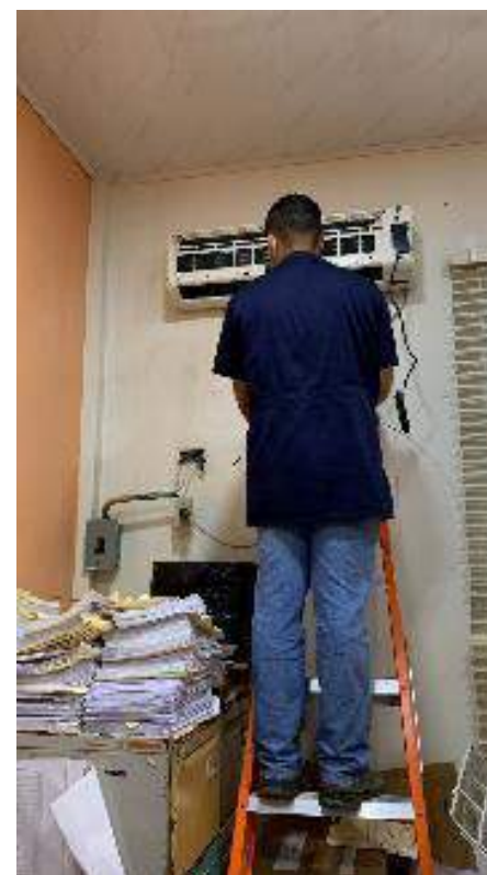
Limpieza de aire acondicionado
