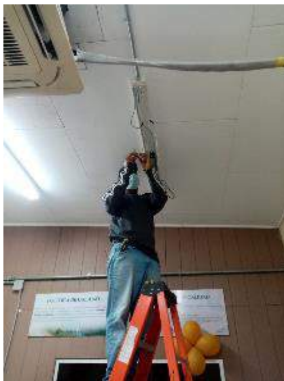
Instalación de tubos Led
