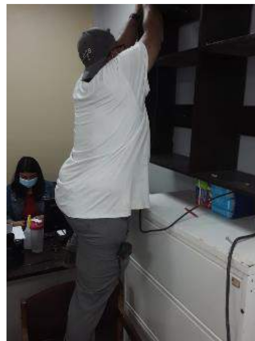
Instalación de estantes
