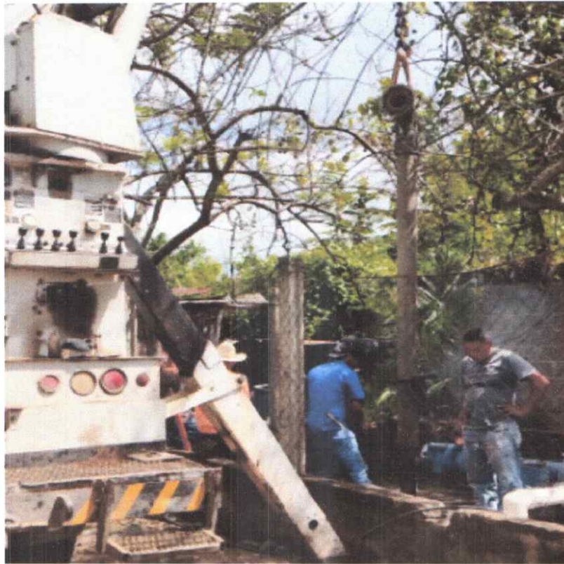
3. Reparación de tubería de impulsión de 6" en Colinas de Suiza.
