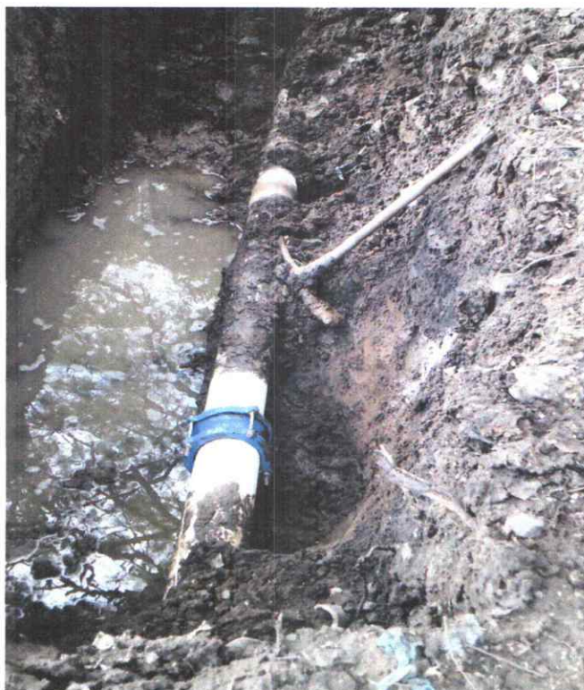
3. Reparación de tubería de impulsión de 6" en Colinas de Suiza.
