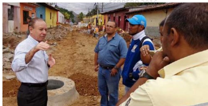
El Alcalde Carlos Miranda supervisó los trabajos en el Paseo Los Monumentos.
