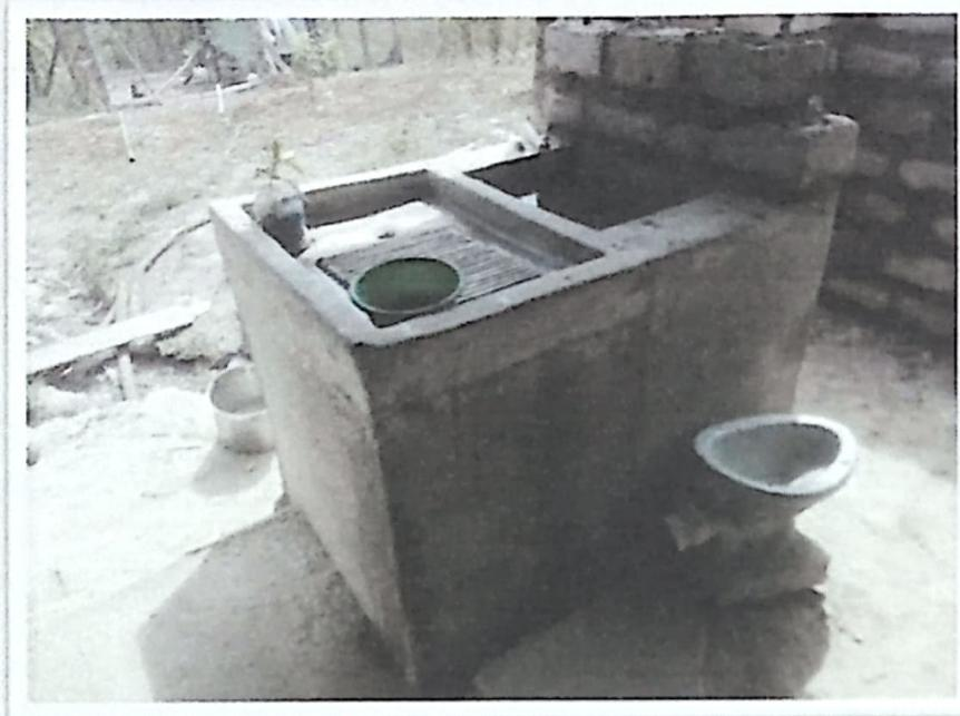
Ilustración 5. CONSTRUCCION DE PILA CON RIBAL
