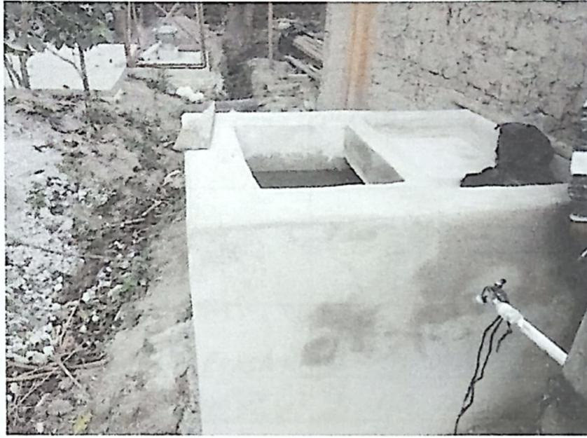
Ilustración 7. CONSTRUCCION DE PILA CON RIBAL
