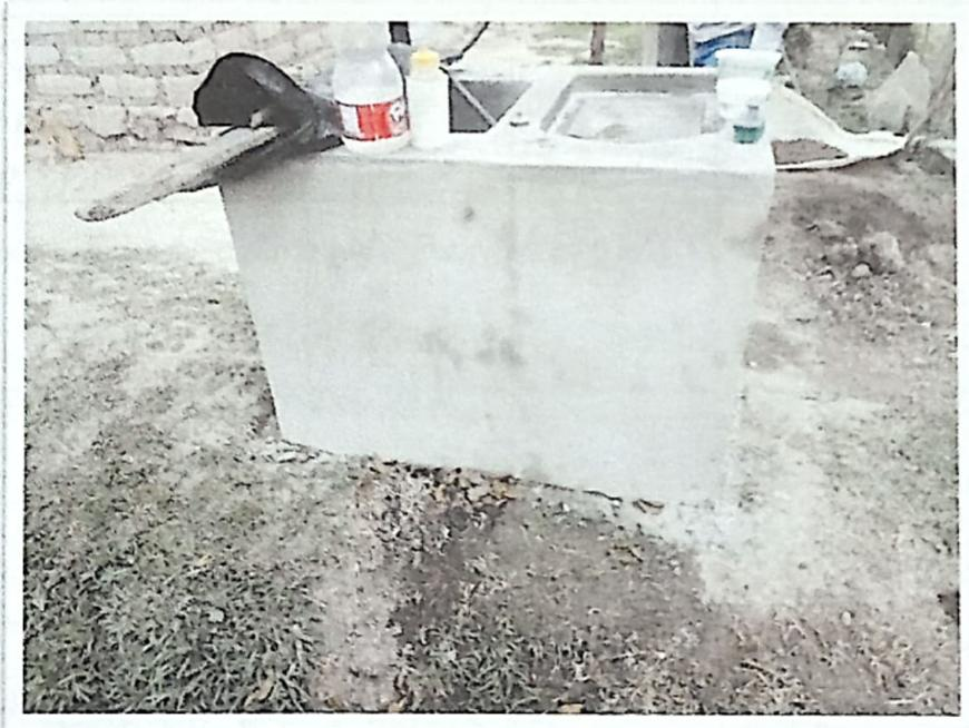
Ilustración 8. CONSTRUCCION DE PILA CON RIBAL
