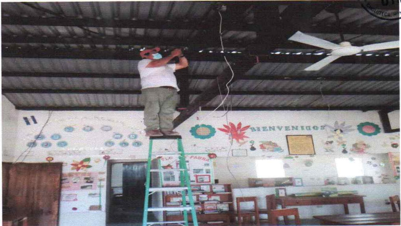
Figura No.6, Revisión e instalación de diversos circuitos incluye, circuitos para aires acondicionados
