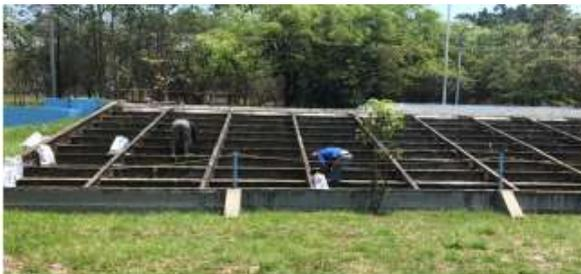
Revisión, reparación de Aerador (sellado grietas) y zona de precloración.
