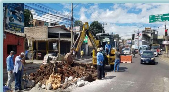
19) **Séptima Avenida de Comayagüela:** Se realizó proyecto de sustitución de tubería de concreto por tubería PVC en aproximadamente 30 metros lineales, debido a que el sistema de alcantarillado sanitario había colapsado y los negocios de ese sector no podían evacuar las aguas residuales, se trabajó de manera continua hasta altas horas de la noche ya que es una zona de alto tráfico vehicular.
