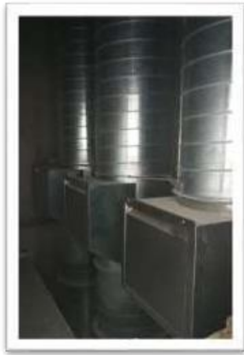
Fig. 1. Ductos de las basuras en el Edificio 1847
