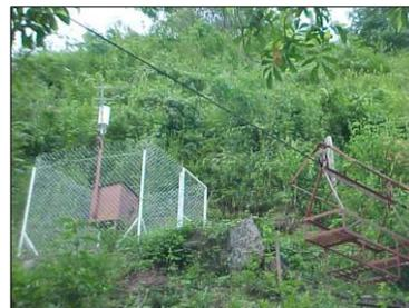
Donde se necesita cambiar la canastilla de aforo por estar en mal estado, impidiendo la realización de aforos en niveles altos. Se necesita pintura anticorrosiva para proteger la caseta del equipo telemétrico. Además de cambiar las escalas por estar en mal estado, además que hacer topografía en la estación (sección de aforo). Para calibración de curva con la siguiente descripción.
