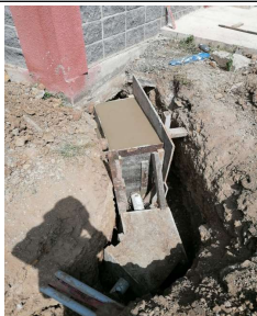
Trabajos de Instalacion de Tuberia y Caja de Registro para Instalaciones electricas que van a cuarto de control.
