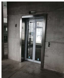
Intalacion de Puerta Elevador en Edificio Administrativo.
