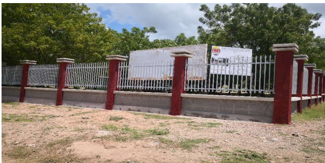
No 3.- Sector "D" del muro perimetral concluido al 100 %
