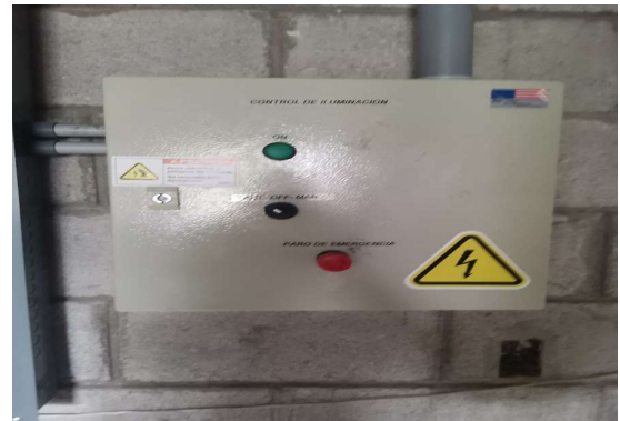
No 2.- Instalación de paneles para el control de iluminación
