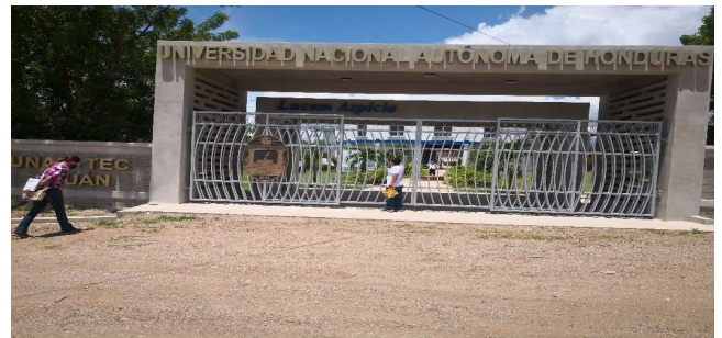
No 4.- Portal de acceso peatonal, con letras encajadas en losa y pared del muro
