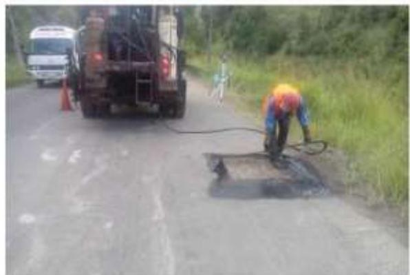
Imprimación asfáltica pre colocación de mezcla asfáltica
