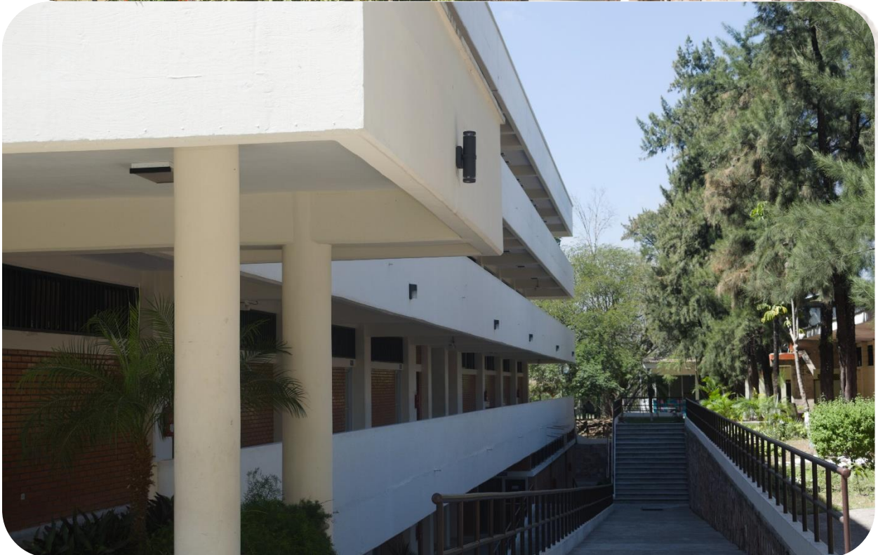
Imágenes del Edificio No 14, Campus Central
