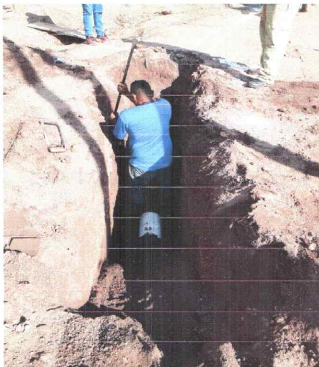
5. Reparación de tubería de impulsión de 6" en Col. Monte Carmel.
