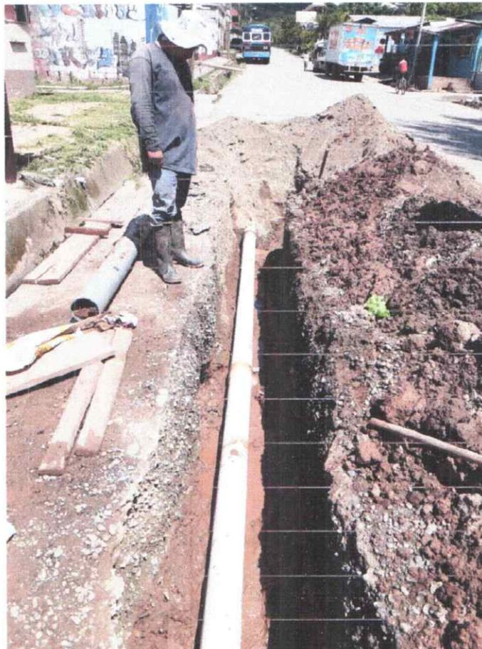
2. Reparación de tubería de distribución de 6" en Col. Renacer, El Marañón.
