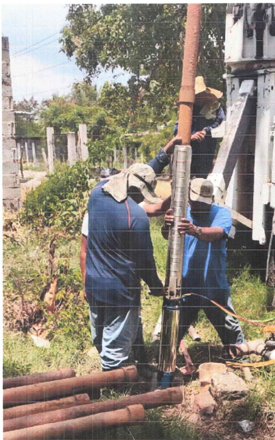
10.Reparación de tubería de impulsión de 3" en KM 71.
