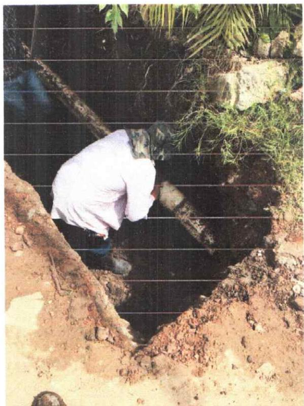
3. Reparación de tubería de impulsión de 8" en Pozo #6, Zona Cañera.
