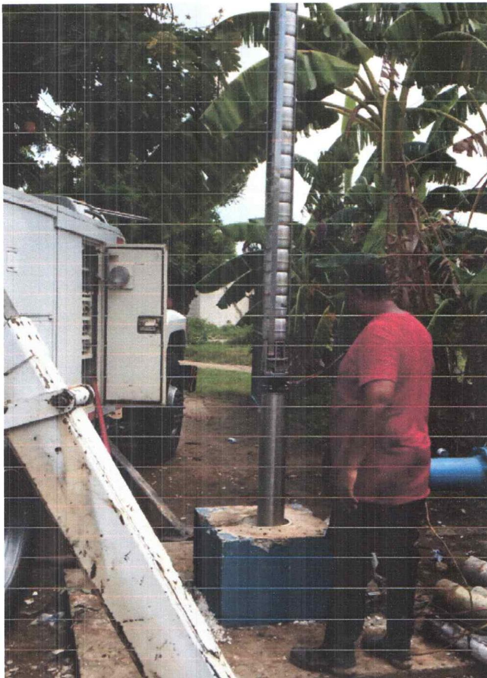
9. Extracción e instalación de equipo sumergible de 10 HP en el Pozo Shalom.
