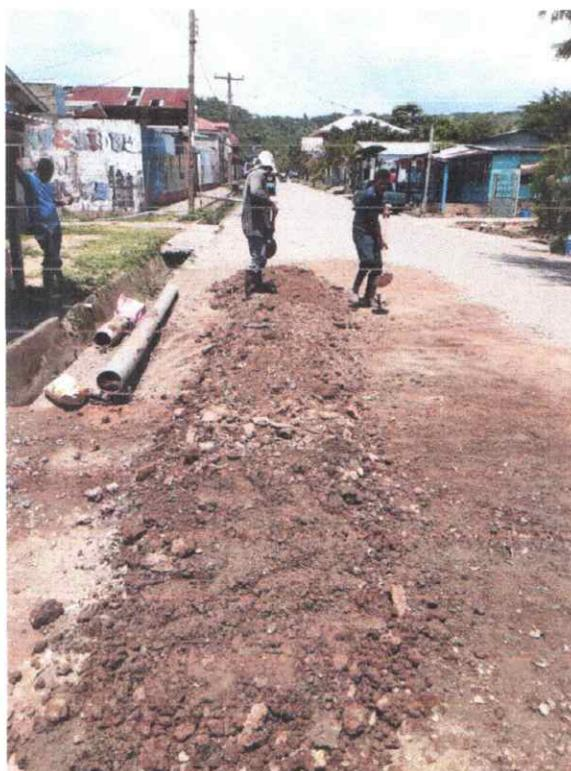
6. Reparación de tubería de impulsión de 12" en Bo. Cabañas.
