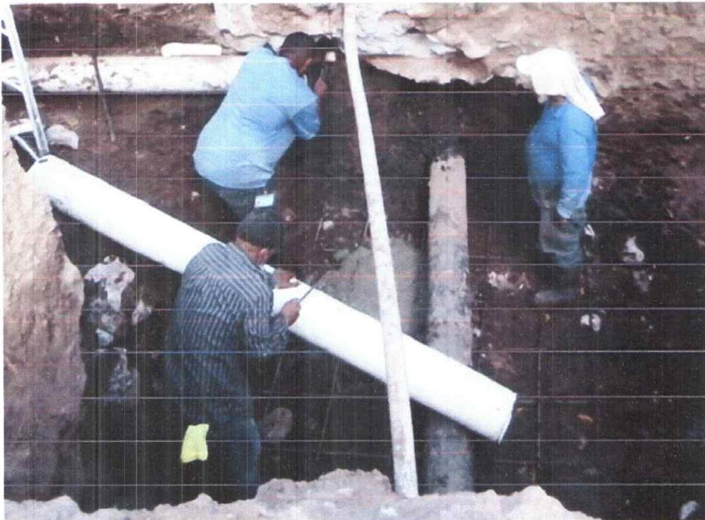
4. Reparación de tubería de impulsión de 6" en El Marañón.
