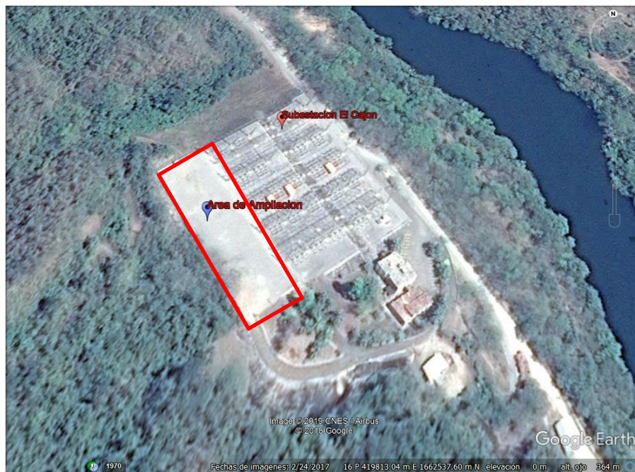
Imagen 7. vista Satelital de la actual Subestación El Cajón y su área de Ampliación.
