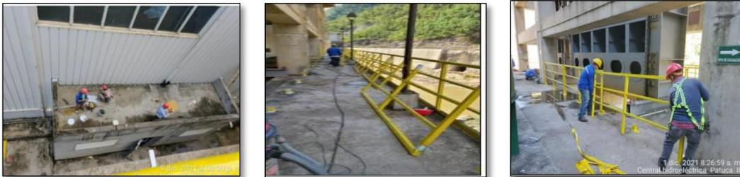
Mantenimiento en Cuarto de Generador Auxiliar Diesel H ( Generador auxiliar de 0.50 MW y 1.00 MW) cambio de baterías, revisión general, Inspección de niveles de aceite.
