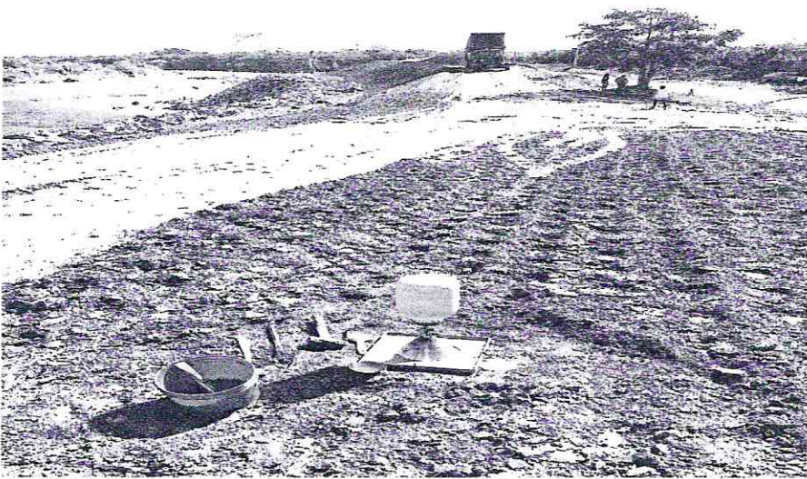
Avance físico Noviembre 2021 proyecto: Rehabilitación de tramos de bordo y obras de protección de márgenes del río Chamelecón sectores guaruma 2 y finca Colombia.
