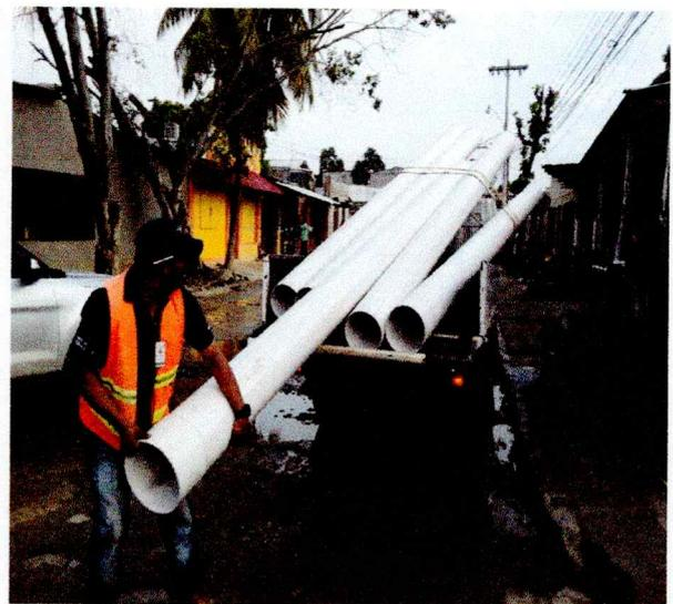
CAMBIO DE 285 METROS DE TUBERIA DE ALCANTARILLADO SANITARIO POR PROYECTO DE PAVIMENTACIÓN EN COL. PLANETA
